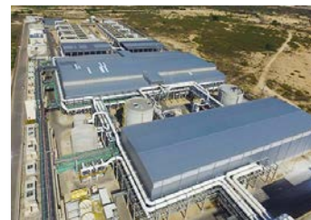
이스라엘 Sorek 2 열병합 발전설비 개조 사업
