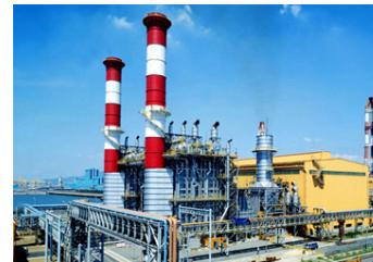
광양 LNG CCGP 개조 사업
